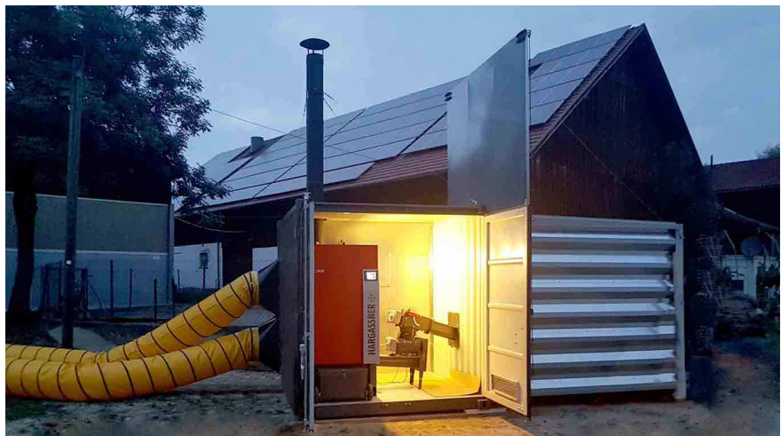
Hargassner kan levere såkalt PowerBox varmluftscontainer med 120–220 kW som standardefekt. Den kan også leveres opp til 330 kW, og er beregnet for korn-/flis-tørker/gårdsanlegg og kan leies ut som byggvarme utenfor sesong. Leveres både for pellets, flis og briketter. Foto: Hargassner
